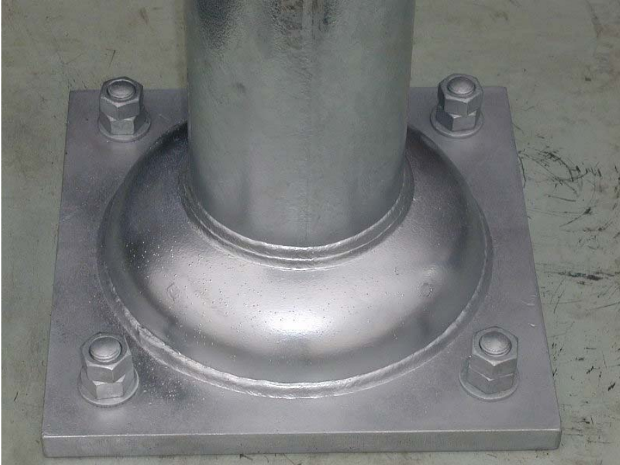
基部部分詳細写真
